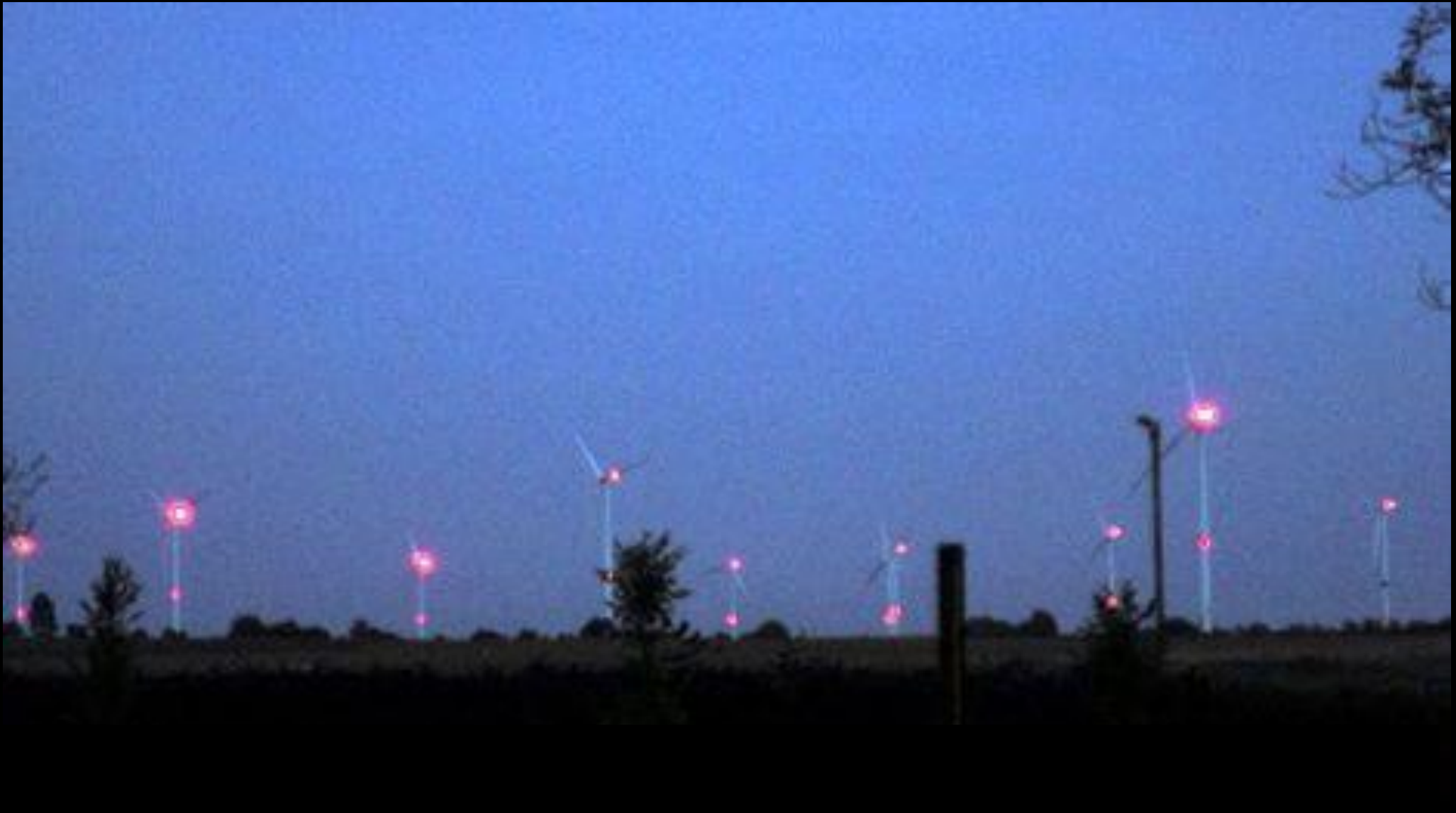
Parc éolien de Perwez (Electrabel, Groupe GDF SUEZ) Balisage à mi-hauteur du mât à partir de 150 m hors tout.
