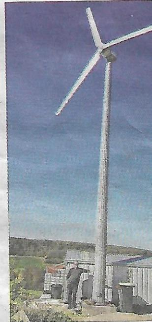
■ L'éolienne est fixée sur base de 16 m<sup>3</sup> de béton. Les branchements souterrains relient dans le garage. Photo
