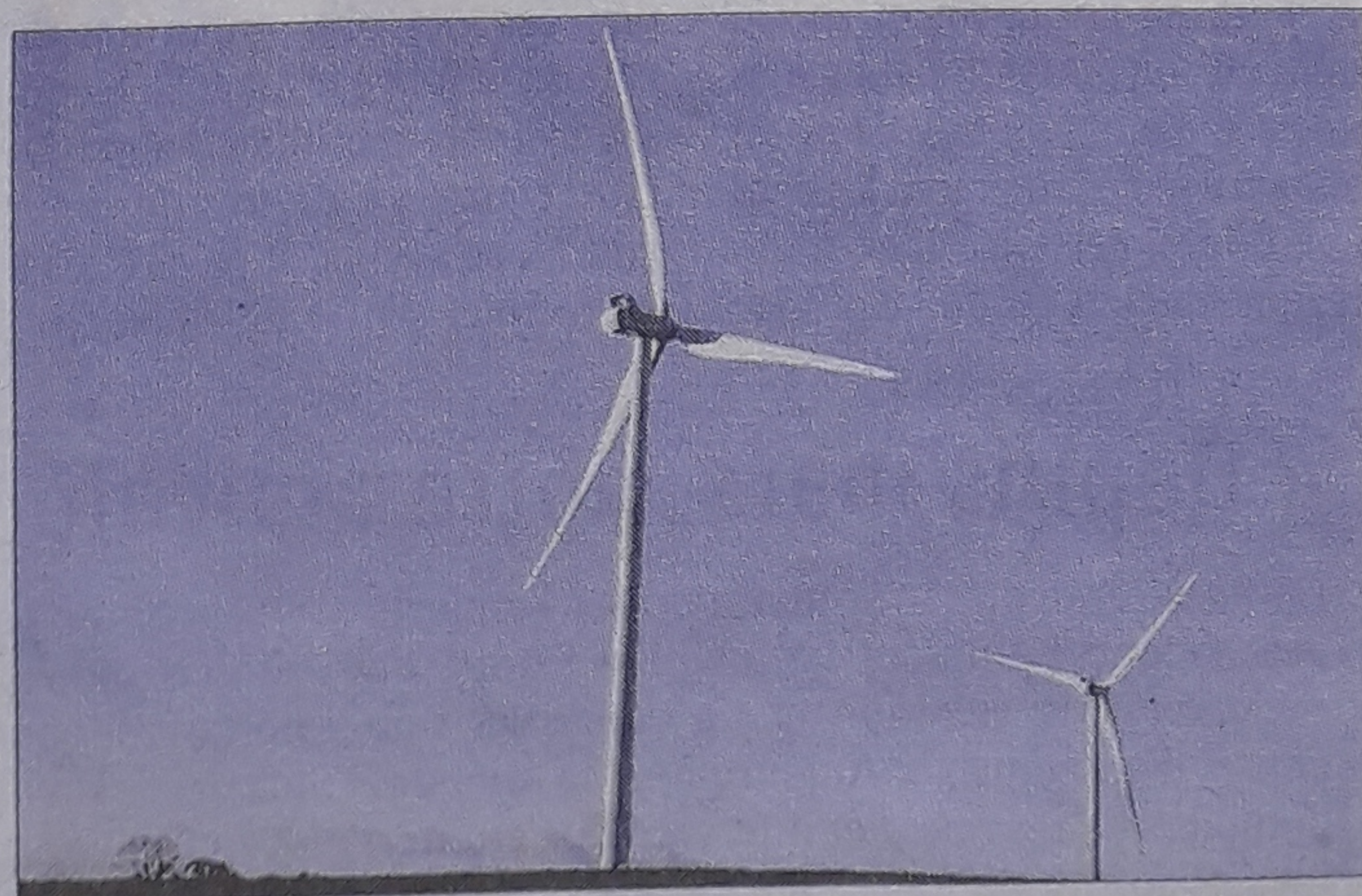
Le projet éolien prévoit l'implantation de quatre éoliennes : une à Lacour-d'Arcenay et trois à Aisy-sous-Thil. Photo d'illustration LBP/Philippe BRUCHOT
